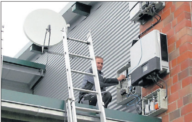
Letzte Handgriffe an der Solaranlage.
